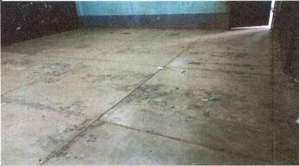
Foto1: Reparación o sustitución de azulejo
