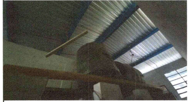
Foto 4: Reparación y mantenimiento de cisternas /depósito de agua
