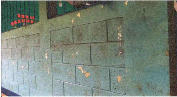
Foto 5: Pintura en muros interior y exterior
