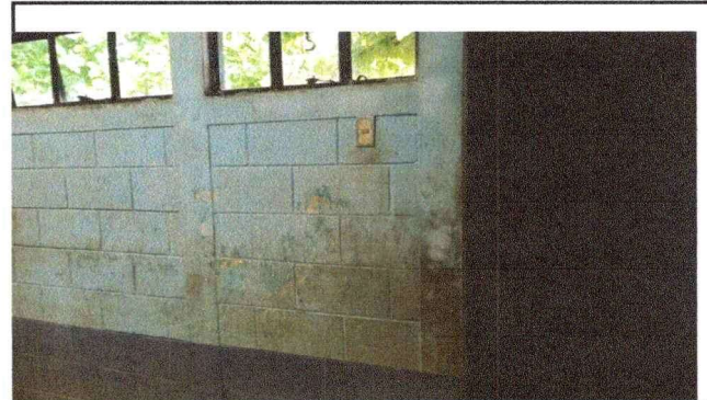
Foto 6: Pintura en muros interior y exterior
