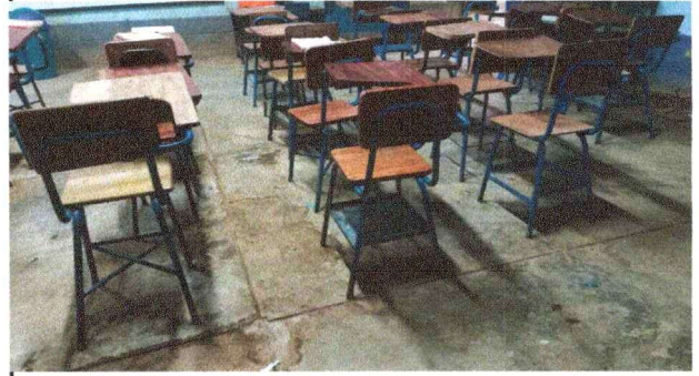
Foto 2: Reparación o sustitución de azulejo
